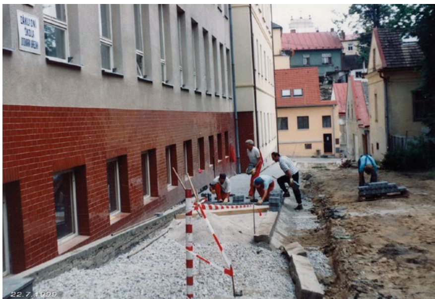
Práce na opravě chodníku a komunikace okolo školy, r. 1999.
