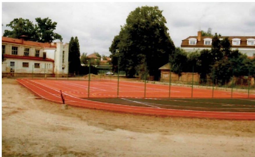
Budování tartanového hřiště v létě 1998
