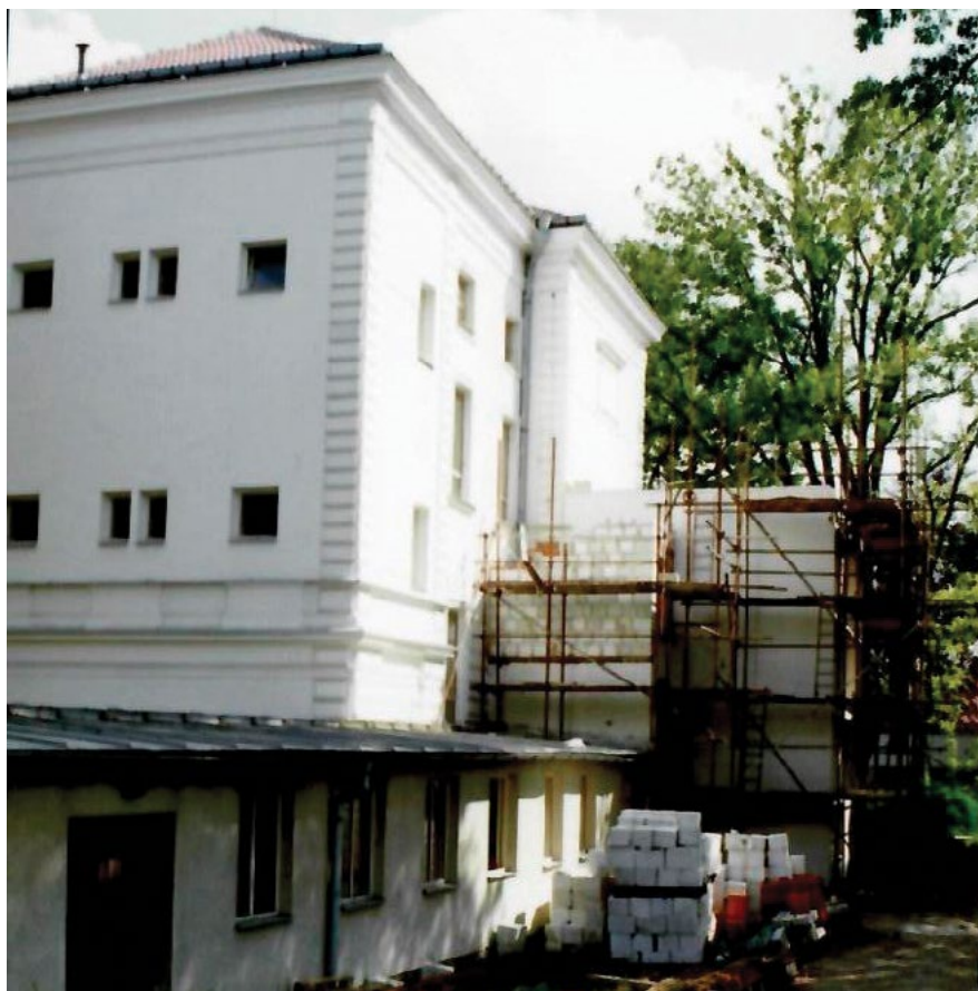
Přístavba plynové kotelny.
