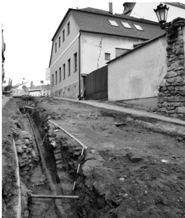
Ve výkopu je patrné 2 m široké kamenné zdivo základu městské hradby. Zeď u č.p. 137 má s původní hradbou pouze společný základ a její nadzemní část neodpovídá síle původní hradby.
