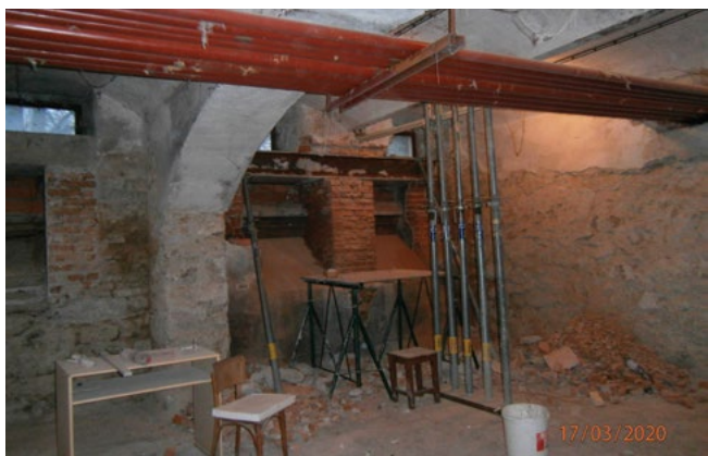
Probíhající práce na přestavbě kotelny na učebnu
