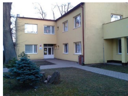
Zateplení a nová okna
