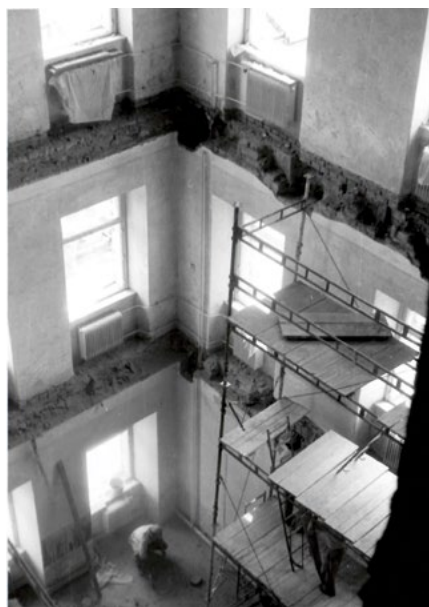
Přestavba – stropy národka
