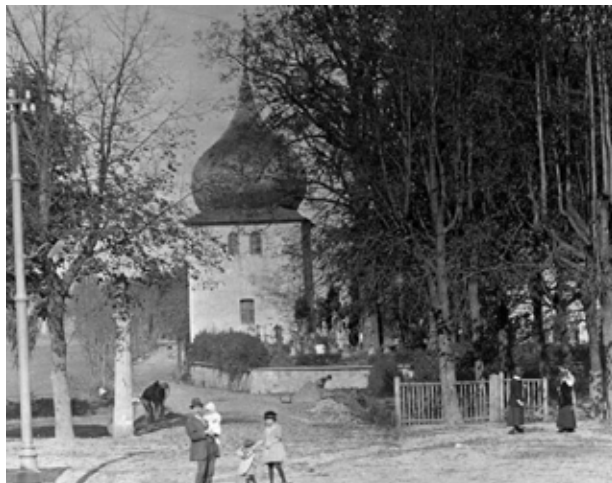
Kopání základů pro přestěhování pomníku
